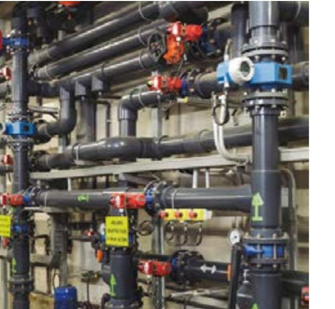
L'Estació Depuradora d'Aigües Residuals (EDAR) de Vallvidrera es basa en un tractament biològic MBR (sistema de biorreactor de membranes). Tracta de manera integrada tota l'aigua residual procedent dels nuclis urbans de Vallvidrera, de les Planes i de la zona del Tibidabo.
